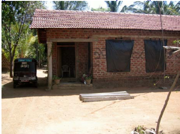
dit huis in Mihintale moet nog worden afgebouwd
