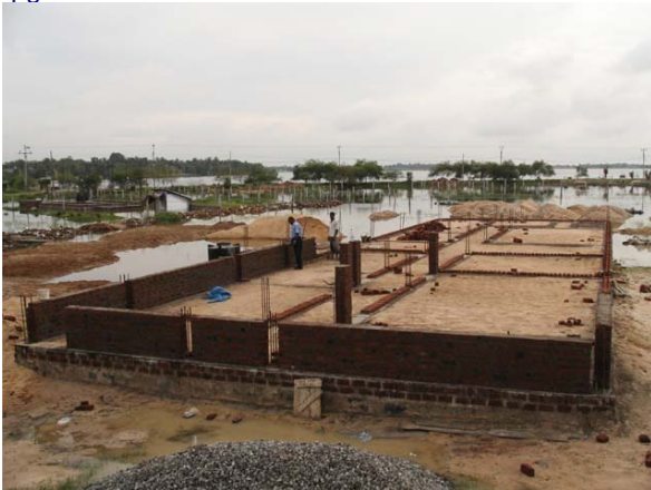
de bouw van school en internaat in Batticaloa
