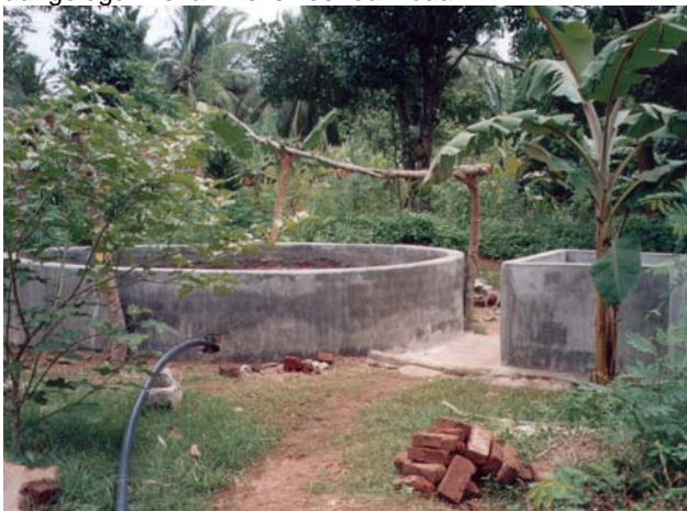
waterput met rand en dagreservoir
